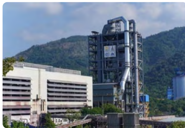
► 磁化焙烧技术改造项目
